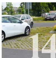
PROPUSTNÝ POVRCH Parkoviště Štruncovy sady
