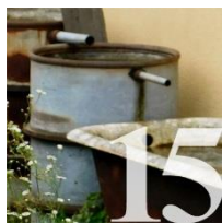
ZADRŽENÍ SRÁŽKOVÉ VODY K ZÁLIVCE Využití srážkové vody k venkovní zálivce u rodinného domu
