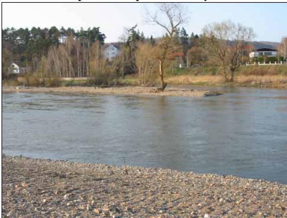
Obr. 29 Popovodňová úprava Berounky v Řevnicích
