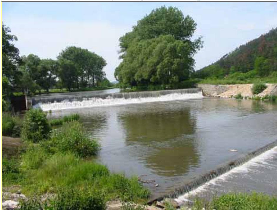
Obr. 49 Starý jez s migrační překážkou a pevnou bariérou
