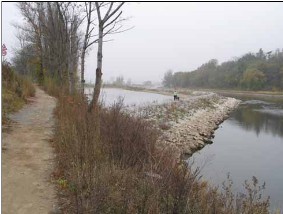
Obr. 32 Koncentrační hráz na Vltavě pod Zbraslaví, obnovená po povodni roku 2002 (pohled v roce 2005, při spuštění modřanského jezu)
