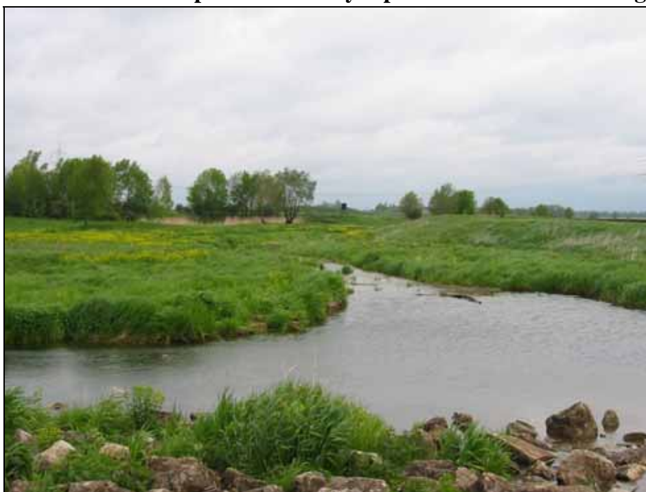
Obr. 41 Ochranné povodňové koryto poblíž bavorského Erdingu
