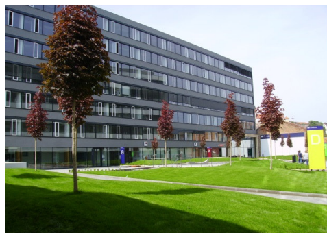
Intenzivní zelená střecha se vzrostlými stromy na střeše garáží administrativní budovy v Brně slouží jako park pro zaměstnance i veřejnost. Rozloha je 1100 m 2 .
